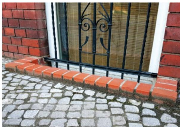
Abbildung 1: Lichtschacht mit kostengünstigem (oberirdischem) Hochwasserschutz (Backsteinreihe); Quelle: GDV
