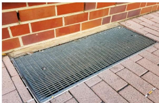
Abbildung 2: Lichtschacht ohne (oberirdischen) Hochwasserschutz; Quelle: GDV
